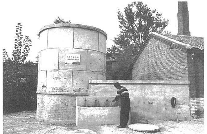
8月中旬、新設された給水塔
